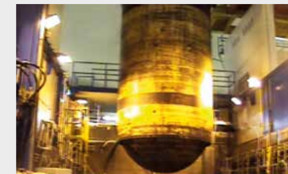
Verlagerung des Reaktordruckbehälters (RDB)
