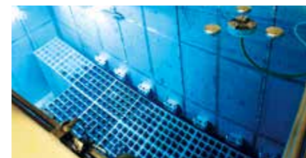
Externes Nasslager Obrigheim
